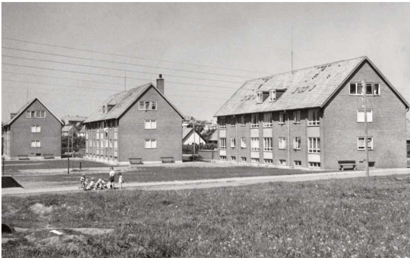
Ejendommene Rahbeks Allé 45-55, fotograferet omkring 1960. De er opført af Esbjerg Kommune og taget i brug i 1950. De indeholder 36 lejligheder. EBA. SK01486-080
